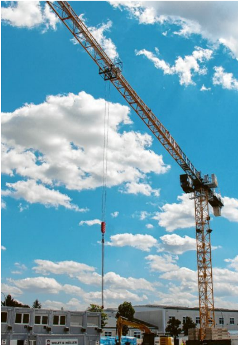
Modern sieht der Kran auf der Baustelle in der Industriestraße aus. Das neue Gerät ist in Wertingen erstmals im Einsatz. Foto: Elli Höchstätter
