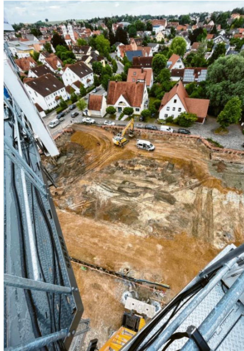
Der Blick von der Kabine aus auf die Baustelle. Im Hintergrund sind die Türme der Wertinger Pfarrkirche St. Martin zu erkennen. Fotos: Uli Herkommer
